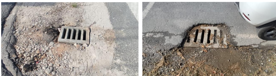
Figura 83 – Componentes do sistema de drenagem pluvial existentes nas ruas de entorno do empreendimento. Fonte: Autor, 2025.
